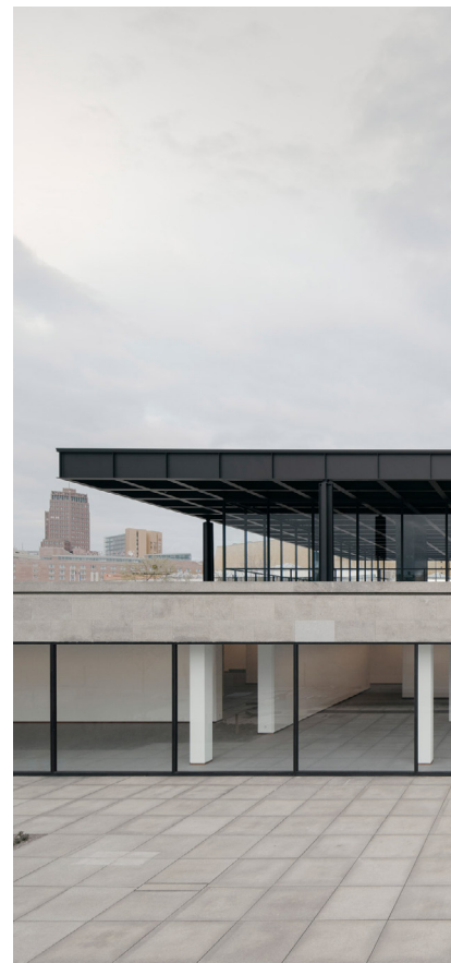
Neue Nationalgalerie Mies Van Der Rohe, 1968 David Chipperfield, 2021
