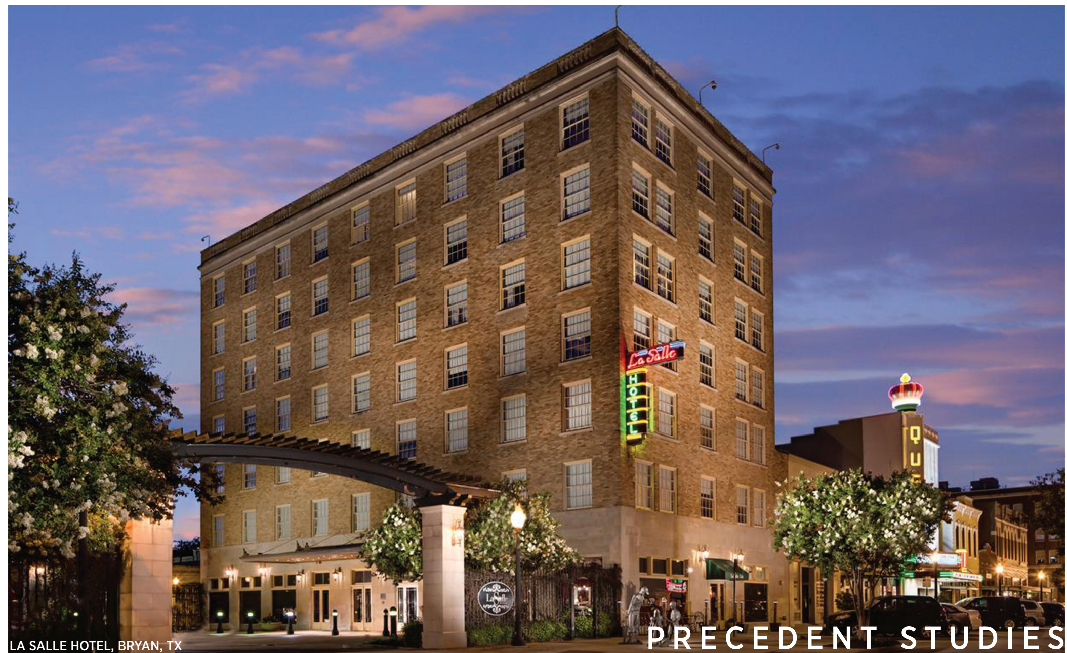
LA SALLE HOTEL, BRYAN, TX
