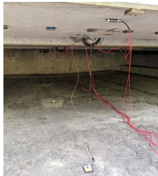
(d) String Pots at Midspan
