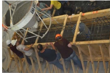
(d) Pocket Anchorage Top View
