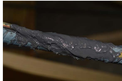
(f) Application of M-Coat JA
