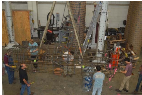
(d) Hoist Steel Cage to Install Chairs
