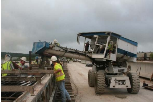
(a) Concrete Pour
