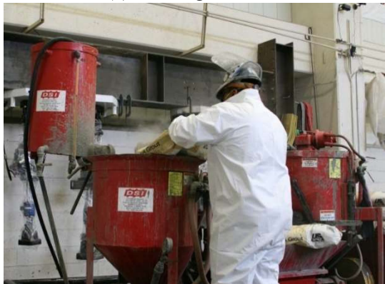
(d) Mixing Grout Mix and Water
