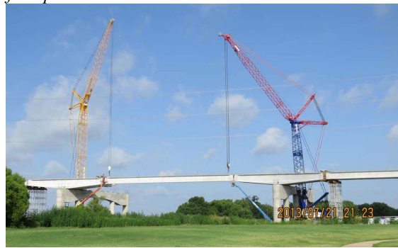
(d) Erection of drop-in segments
