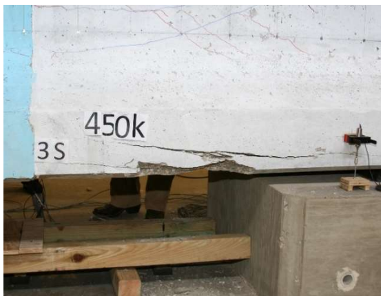
(d) Compression failure in bottom flange ( P=2000 \text{ k} = 450 \text{ k N} )
