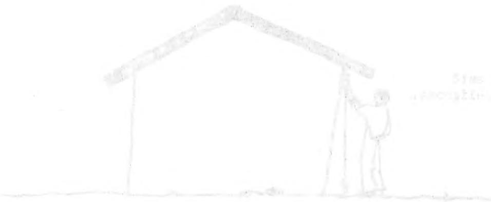
Fig. 3. Se utiliza la plomada para verificar si la pared está perfectamente vertical.
