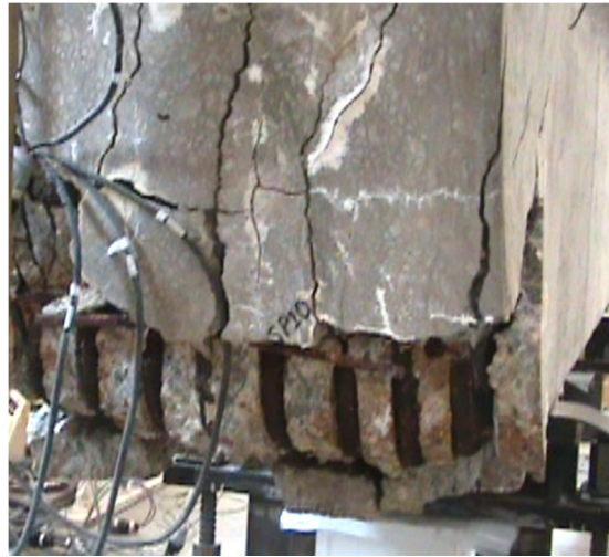
(d) Just after Failure
