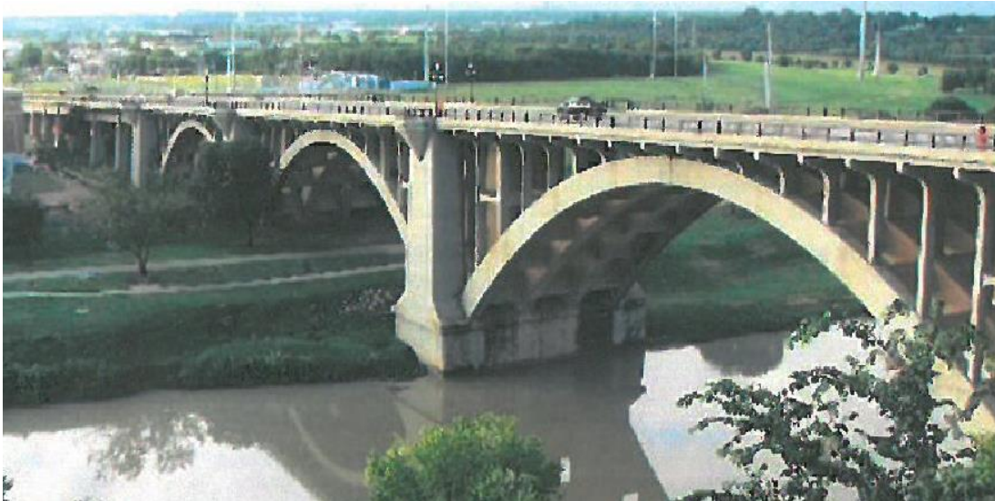
Figure 3-7. BU 287P (N. Main Street) over Clear Fork Trinity River (TxDOT 2012).
