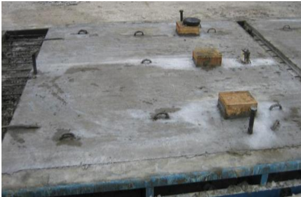
a) Stage I prestressed concrete pour
