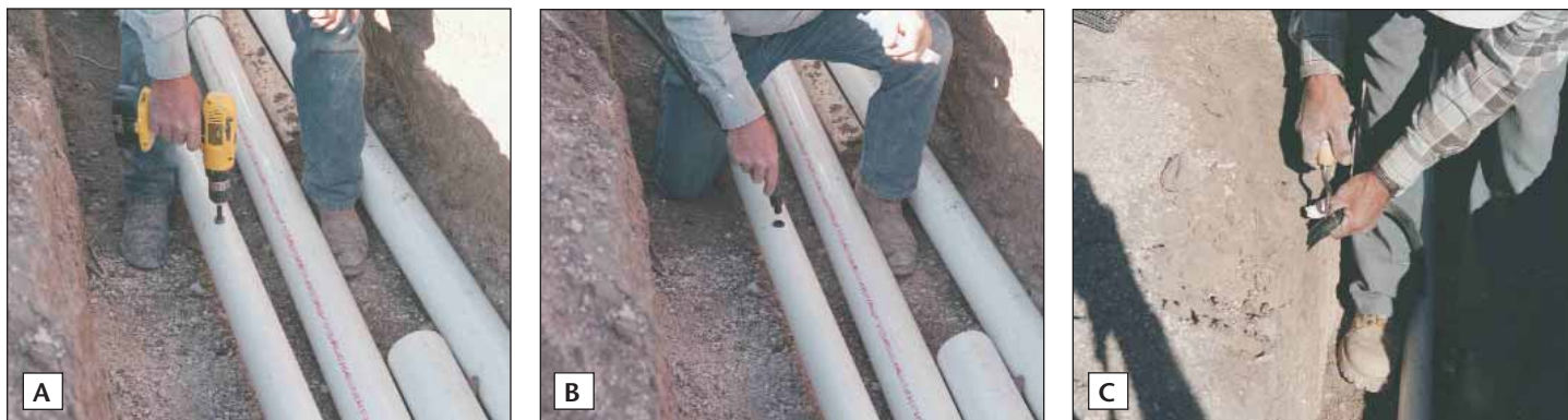
Figura 9. Perforando el tubo distribuidor de PVC (A), metiendo el insertor con manguera de PVC al empaque de plástico que está sobre el tubo de PVC (B) conectando la manguera de PVC a la cinta utilizando un alambre de acero (C).
