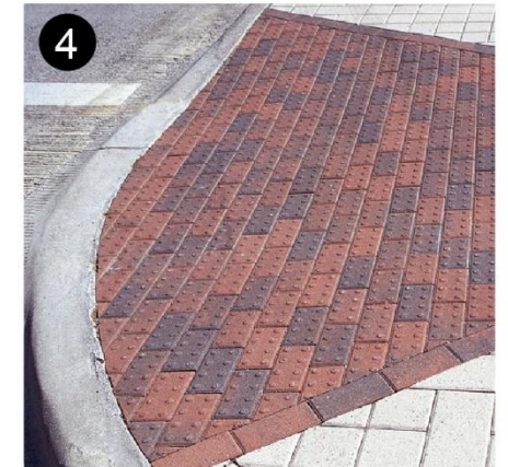
4 ADA Warn Paver
