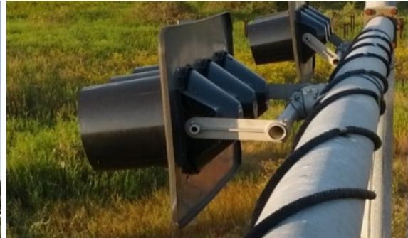
(d) Helical strake installation on the mast arm
