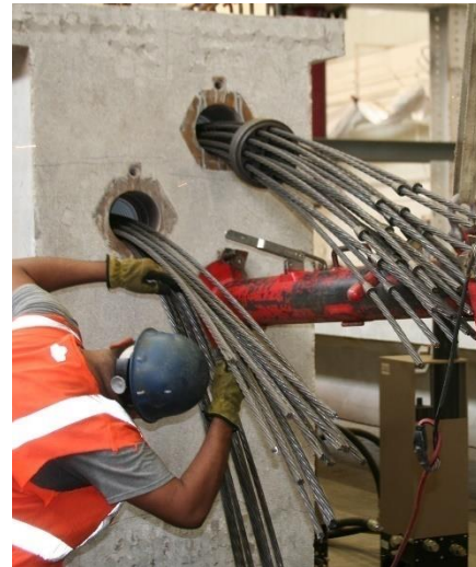
(d) Top duct completed
