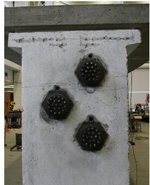
(d) Post-tensioning completed
