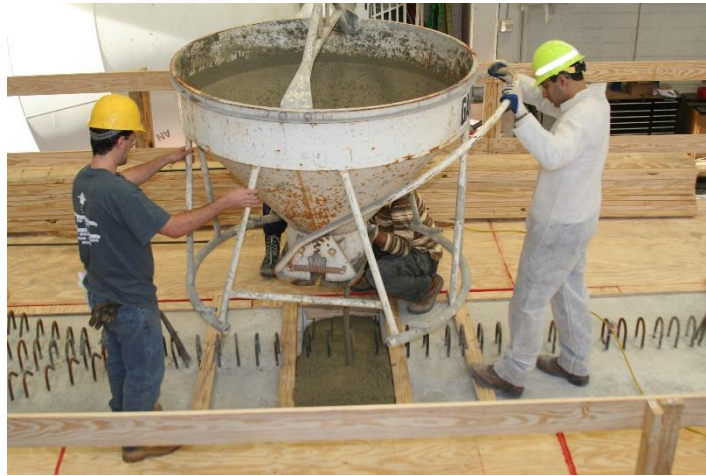
(a) Pouring concrete
